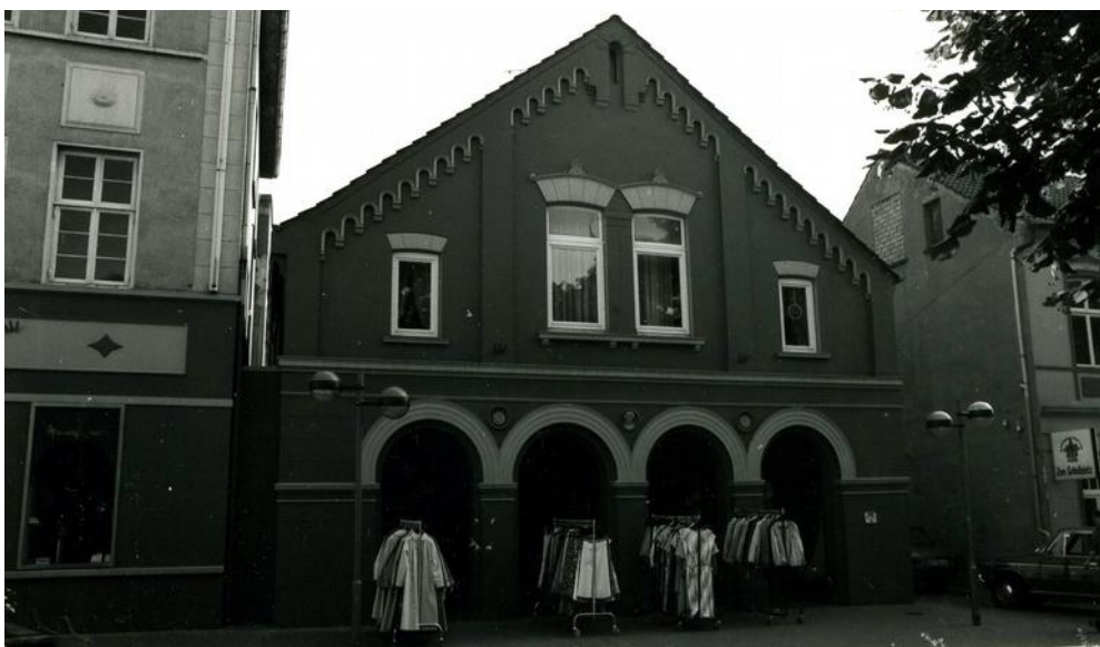
Abb. 7: Heutiger Zustand Gebäude Schlossplatz 12.
