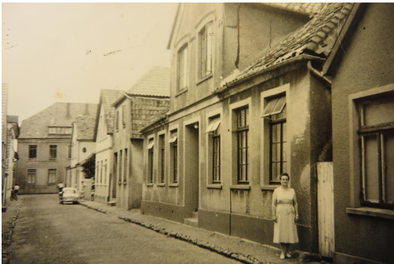
Abb. 5: Varel, Schüttingstraße. Die Person auf dem Foto steht vor der Hausnummer 13, dem ehemaligen Jüdischen Altenheim (1937 bis 1942), 1941/42 Aufenthaltsort von Heimann Glös. Ein zeitgenössisches Foto aus dem Zeitraum 1937 bis 1942 ist bisher unbekannt (Arbeitskreis Weinberghaus Varel).
